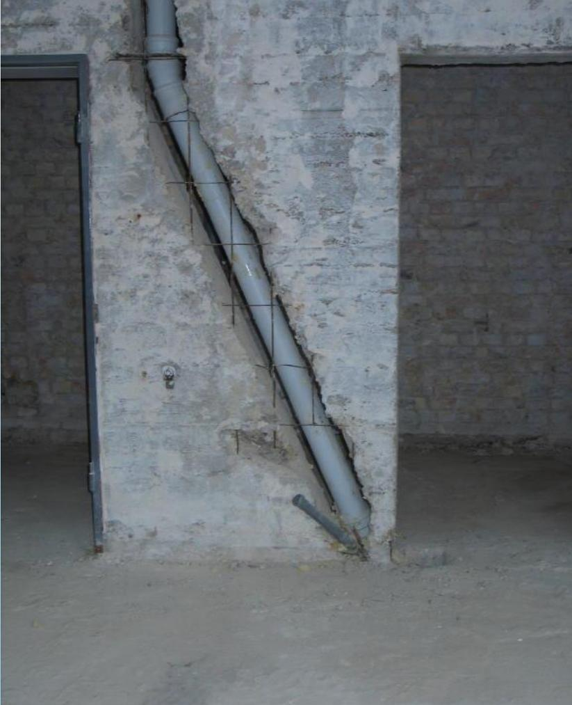
Diese „tragende“ Betonwand wurde nicht mehr benötigt und abgerissen.
